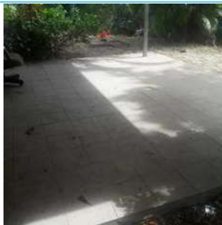
Matériaux : ZPSO-010 Prélèvement : TON 10 Description : Colle de carrelage / Dalle au sol Localisation : RdC - VILLA 15- Terrasse Résultat : Absence d'amiante
