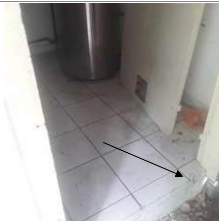
Matériaux : ZPSO-008 Prélèvement : TON 08 Description : Colle de carrelage / Dalle au sol Localisation : RdC - VILLA 15 - Buanderie Résultat : Absence d'amiante
