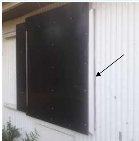
Matériaux : ZPSO-012 Prélèvement : TON 12 Description : Joint de mastic de vitrage (notamment châssis aluminium) Localisation : RdC - VILLA 3 Résultat : Absence d'amiante
