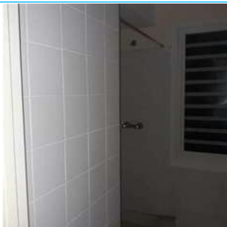
Matériaux : ZPSO-017 Prélèvement : TON 17 Description : Colle de faïence Localisation : RdC - VILLA 23 - Entrée - Douche 1 Résultat : Absence d'amiante
