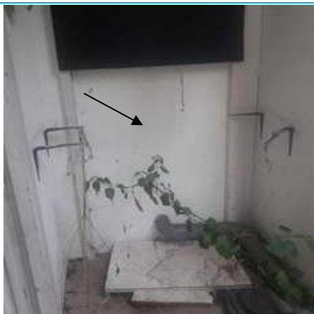
Matériaux : ZPSO-009 Prélèvement : TON 09 Description : Panneaux Localisation : RdC - VILLA 15 - Façade extérieure Résultat : Absence d'amiante
