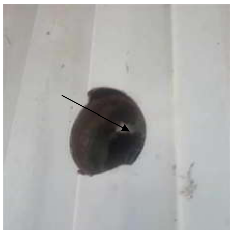
Matériaux : ZPSO-011 Prélèvement : TON 11 Description : Élément de remplissage / Laine de verre Localisation : RdC - VILLA 16 - Façade extérieure Résultat : Absence d'amiante
